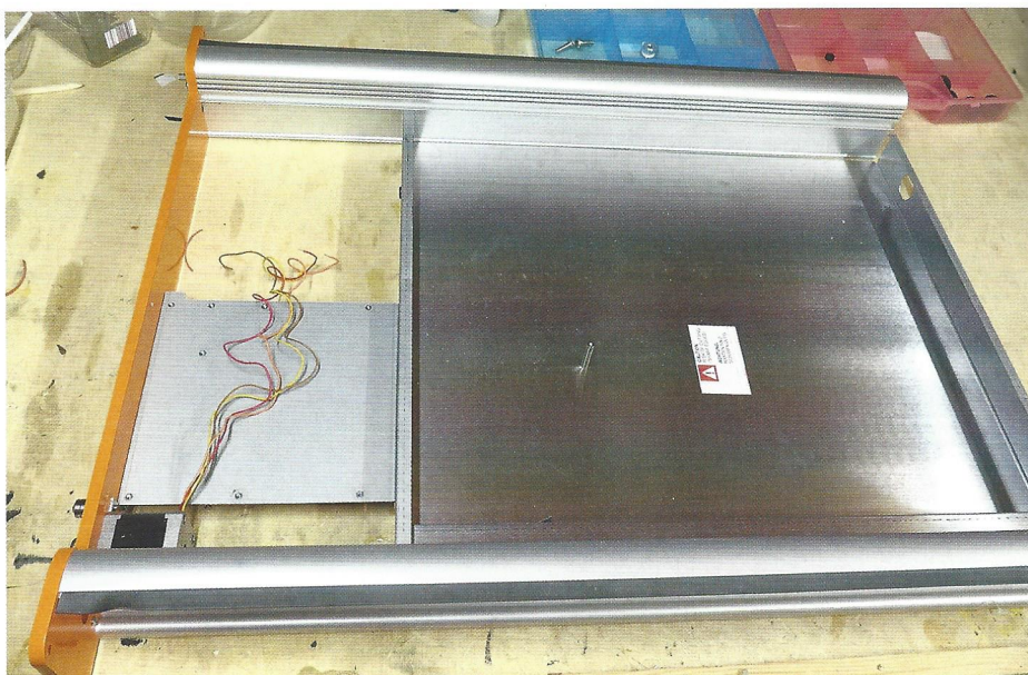
Montage des Unterbaus: Die beiden Y-Führungen sind montiert und mit einem Schrittmotor versehen.
